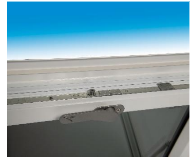
Abbildung 8 Der Griff des Oberlichts in einer um 90 Grad gedrehten Position.
