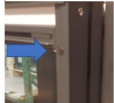
Abbildung 4 Schrauben für das Doppelrollo Model A. Der Pfeil zeigt auf eine dieser Schrauben
