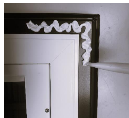
Afbeelding 3 Aanbrengen van lijm op het inbouwdakraam.
