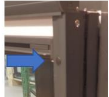
Afbeelding 5 Dubbel rolgordijn model B. De pijl wijst naar één van de deksels, die u kunt openen.
