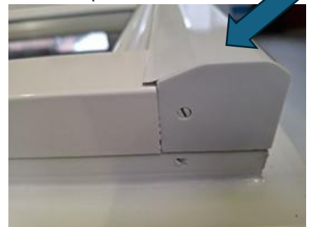
Afbeelding 6 De voorgeboorde schroef gaten die zich bevinden onder de deksels. De pijl wijst naar één van deze gaten.
