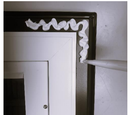
Abbildung 3 Verklebung des Einbaurahmens
