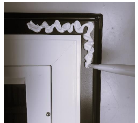
Abbildung 3 Verklebung des Einbaurahmens
