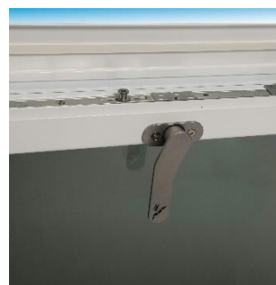
Afbeelding 9 Het dakraam in ventilatie positie
