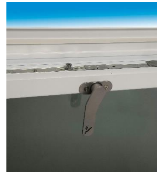
Abbildung 9 Das Oberlicht in Lüftungsstellung.
