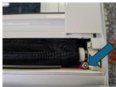
Abbildung 5 Die vorgebohrten Schraubenlöcher befinden sich unter den Abdeckungen. Der Pfeil zeigt auf eines dieser Löcher.
