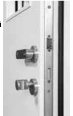
Abbildung 8 Seitenansicht der Innenseite der Tür, mit Verriegelungsknopf.
