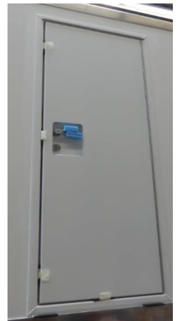
Abbildung 4 Abstandshalter, um die Tür während der Montage in der richtigen Position zu halten.
