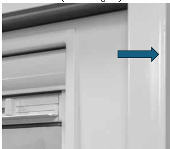
Afbeelding 19 De pijl wijst naar de plek van inkeping, waar u wanneer nodig gaatjes kunt boren om de plisséhor met schroeven te bevestigen.
