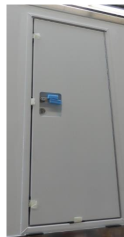
Afbeelding 5 Afstandsplaatjes om de deur op de juiste positie te houden tijdens montage.
