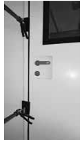
Afbeelding 6 De deur wordt gefixeerd in de wand doormiddel van steunen, dit is een voorbeeld maar kan eventueel ook met tape.
