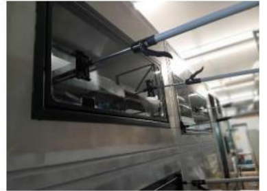
Abbildung 7 Während des Trocknungsprozesses wird das Fenster durch Stützen in die Wand gedrückt.
