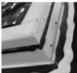
Afbeelding 5 Lijm aangebracht op het frame van het inbouwraam.
