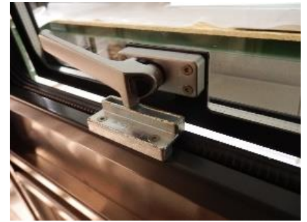
Abbildung 11 Edelstahlgriff mit schwarzem Verriegelungsknopf. Das Fenster befindet sich hier in der Lüftungsstellung.
