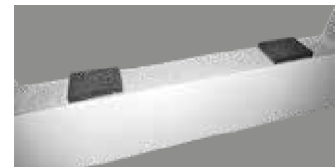
Abbildung 4 Gummistreifen an der Unterseite der Aussparung, um das Fenster während der Montage auf der richtigen Höhe zu halten.
