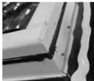
Abbildung 5 Klebstoff auf den Rahmen des vertieften Rahmens aufgetragen
