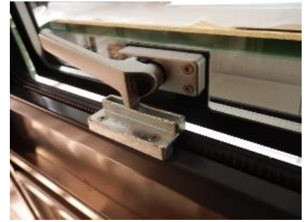
Afbeelding 11 Handreep van roestvrijstaal met een zwart vergrendelingsknop. Het raam staat hier in de ventilatiestand.
