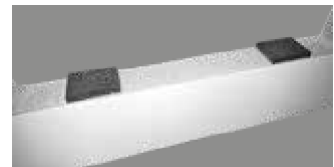
Abbildung 4 Gummistreifen an der Unterseite der Aussparung, um das Fenster während der Montage auf der richtigen Höhe zu halten.
