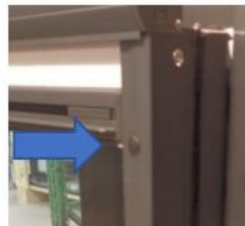
Afbeelding 8 Dubbel rolgordijn model B. De pijl wijst naar één van de deksels, die u kunt openen.
